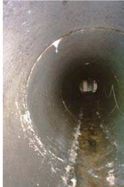
Bild 2 Blick in den Vortriebsrohrstrang DN/ID 1600 mit komplett ausgebranntem GFK-Inliner (das Feuer wurde während der Demontage einer Zwischenpressstation durch einen defekten Schweißbrenner verursacht) [26]
