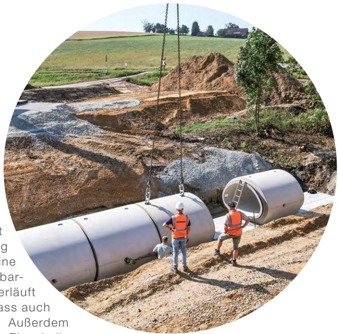
Die verbauten Maulprofile aus Stahlbeton sind extrem belastbar und bewältigen hohe Durchflussmengen.
